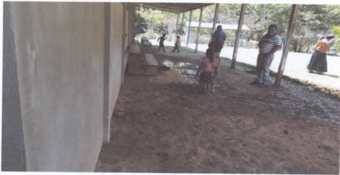
Sustitución de piso de tierra por Torta de cemento
