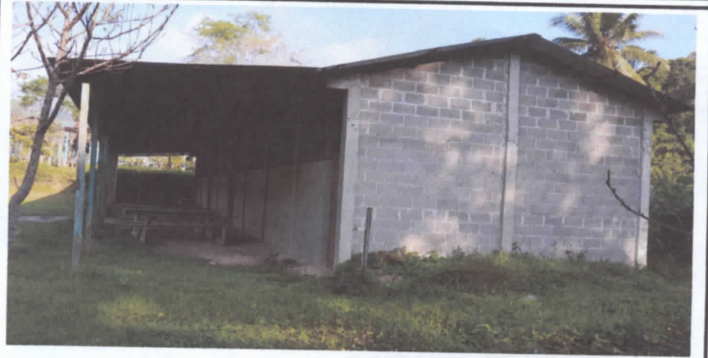
Sustitución de láminas, por láminas troquelada aluzinc C26
