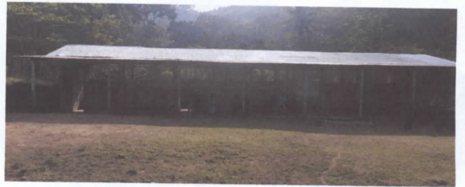
Sustitución de láminas, por láminas troquelada aluzinc C26
