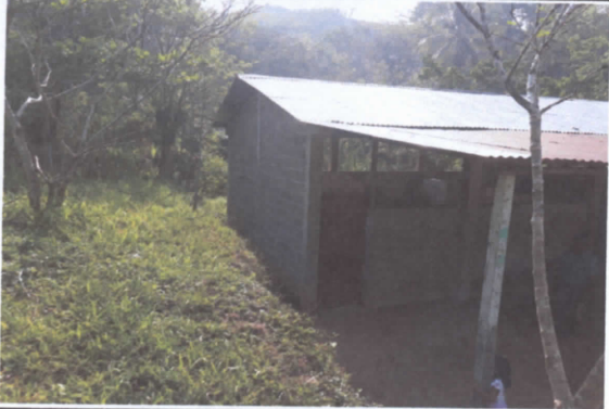
Sustitución de láminas, por láminas troquelada aluzinc C26
