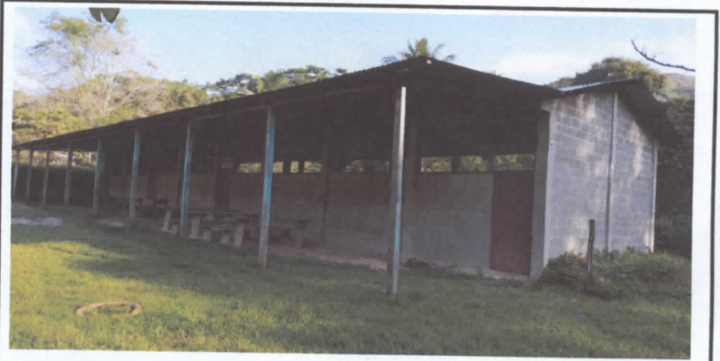
sustitución de estructura de soporte de techo de madera
