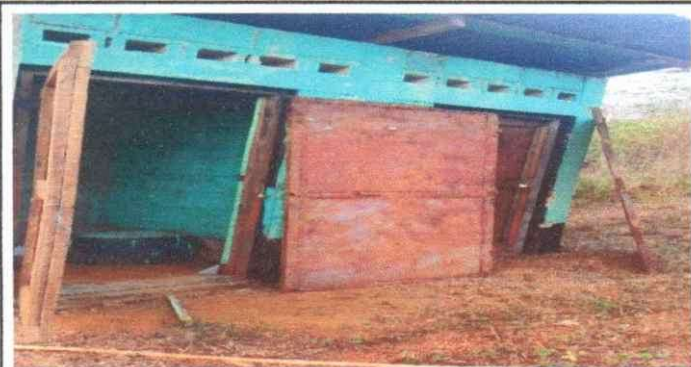
Foto. No. 3. sustitución de puertas en servivios sanitarios
