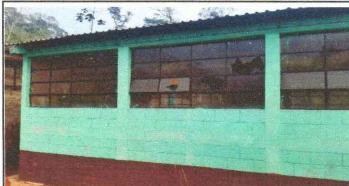
Foto No. 4. Sustitución de balcones de metal
