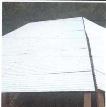
FOTO 1: SUSTITUCIÓN DE LAMINA POR LAMINA TROQUELEADA
