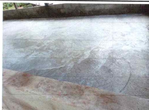
FOTO 4: FABRICACION DE MURO Y REPELLO, TORTA DE PISO
