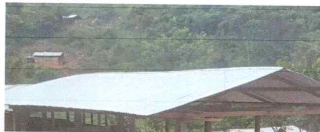
FOTO 2: SUSTITUCIÓN DE ESTRUCTURA
