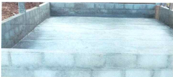
FOTO 3: FABRICACION DE MURO Y REPELLO, TORTA DE PISO
