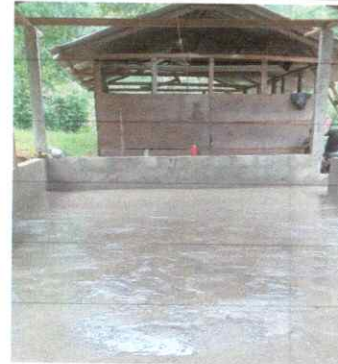
FOTO 4: FABRICACION DE MURO Y REPELLO, TORTA DE PISO
