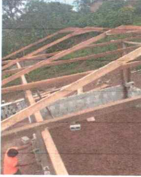
FOTO 1: SUSTITUCIÓN DE LAMINA POR LAMINA TROQUELEADA
