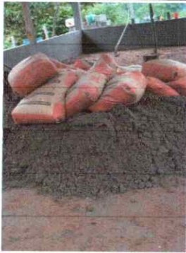
FOTO 3: FABRICACION DE MURO Y REPELLO, TORTA DE PISO
