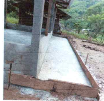
FOTO 2: SUSTITUCIÓN DE ESTRUCTURA
