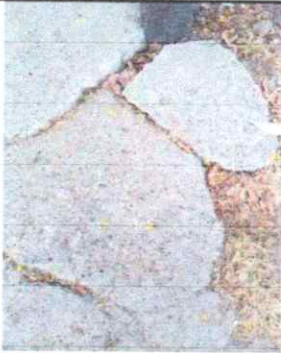
FOTO 3: REPARACION DE PISO TORTA
