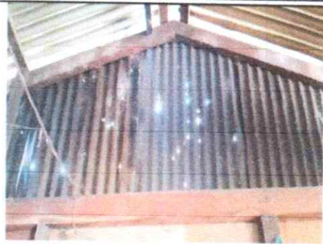
FOTO 2: SUSTITUCION DE ESTRUCTURA DE MADERA POR METAL
