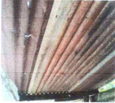
FOTO 1: SUSTITUCION DE LAMINA POR LAMINA TROQUEALDA
