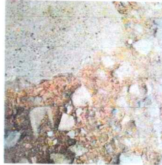
FOTO 4: REPARACION DE PISO TORTA
