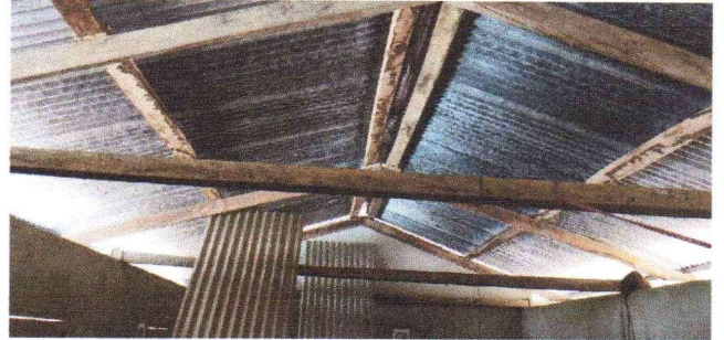
FOTO 2: Sustitucion de soporte de madera por metal
