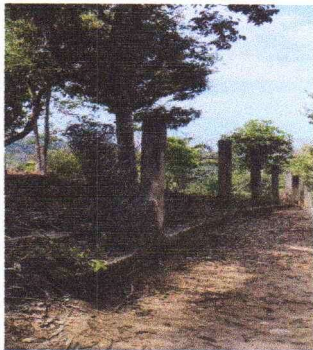
FOTO 4: Reparacion de muro perimetral
