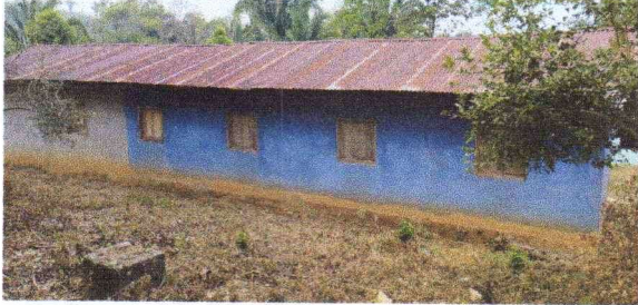
FOTO 5: Sustitucion de Lamina
