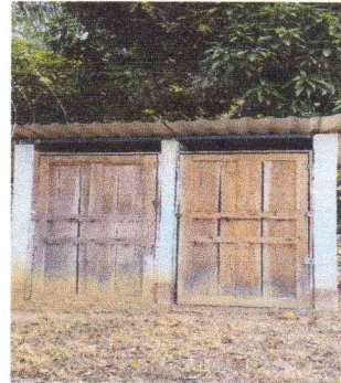
FOTO 4: Sustitucion de Puertas de Servicio Sanitario
