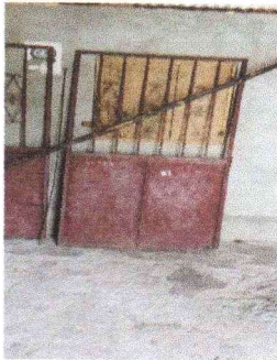
FOTO 3: Sustitucion de Puertas de metal
