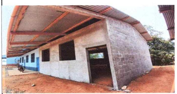
FOTO 8: SUSTITUCIÓN DE MADERA POR BLOCK.
