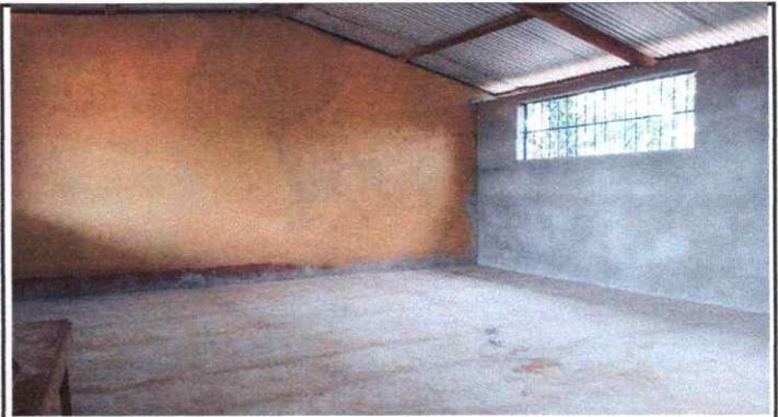
FOTO 4: REPELLO DEL MURO EXTERIOR E INTERIOIR DE UN AULA.
