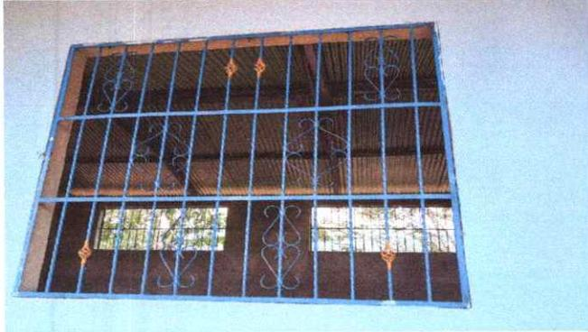
FOTO 1: SUSTITUCIÓN DE VENTANAS DE MADERA POR BALCONES DE METAL.
