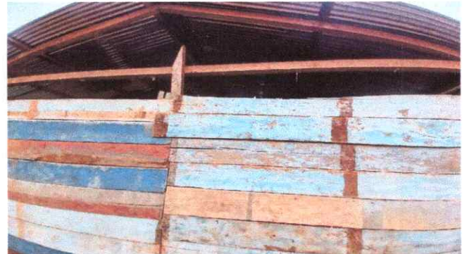
FOTO 8: SUSTITUCIÓN DE MURO DE MADERA POR BLOCK.
