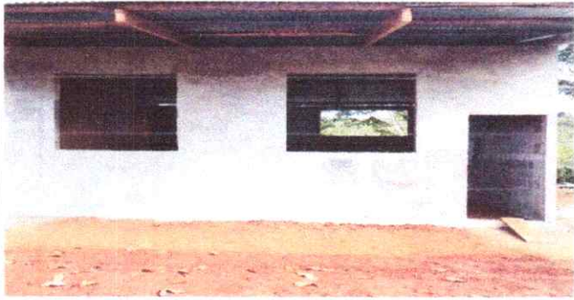
FOTO 1: SUSTITUCIÓN DE VENTANAS DE MADERA POR METAL.
