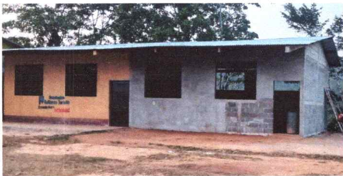
FOTO 3: SUSTITUCIÓN DE PUERTAS DE METAL
