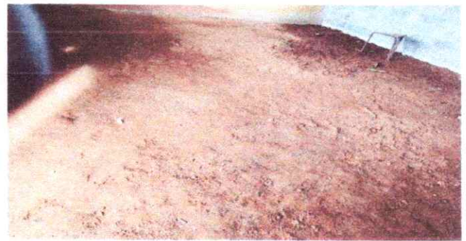
FOTO 2: SUSTITUCIÓN DE PISO DE TORTA DE CONCRETO.
