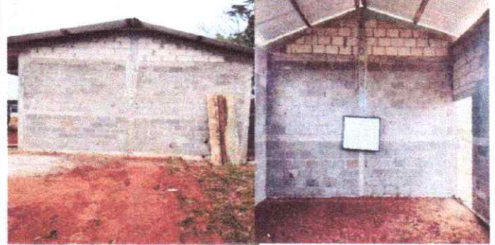
FOTO 4: REPELLO DEL MURO EXTERIOR E INTERIOR DE UN AULA.
