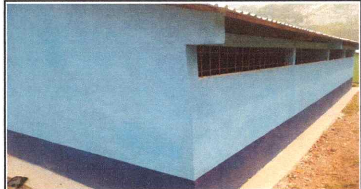
Foto # 4 Pintado de paredes
