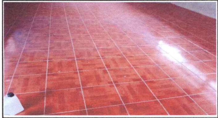
Foto # 2 Sustitucion de piso ceramico.
