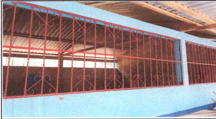
Foto # 1 Sustitucion de valcones
