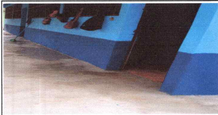
Foto # 3 Sustitucion de piso de torta de cemento
