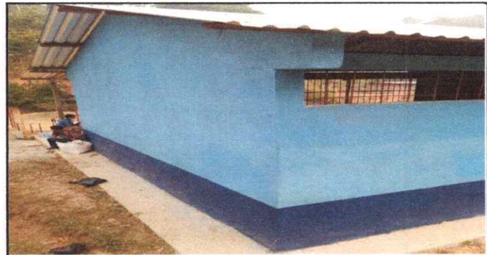
Foto # 6 Reparacion de losa de corredor.
