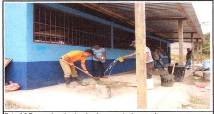
Foto # 6 Reparacion de plancha de concreto de corredor.
