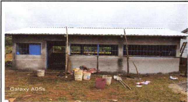
FOTO 3: INSTALACIÓN DE LAMINA TROQUELADA
