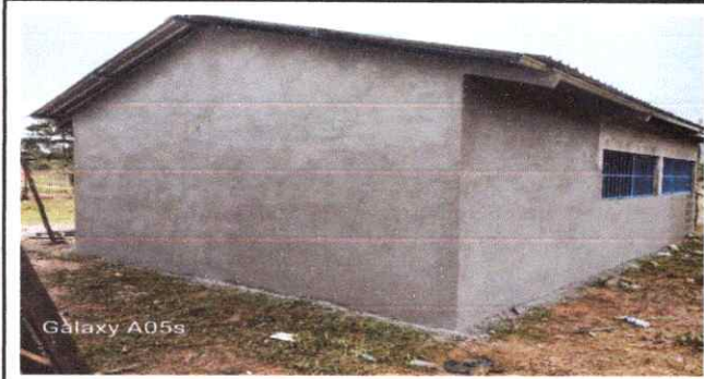
FOTO 1: LEVANTAMIENTO DE MURO
