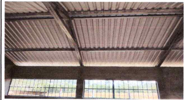
FOTO 2: INSTALACIÓN DE ESTRUCTURAS METALICAS
