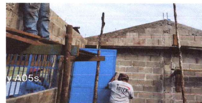
FOTO 5: SUSTITUCIÓN DE PUERTA DE METAL
