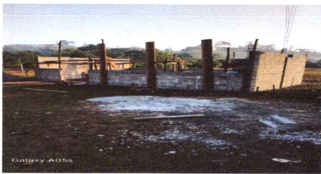
FOTO 1: LEVANTAMIENTO DE MURO
