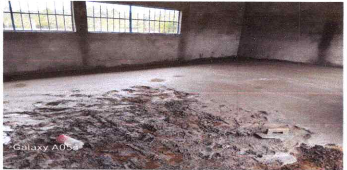
FOTO 6: SUSTITUCIÓN DE PISO DE TORTA
