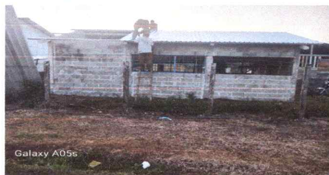
FOTO 3: INSTALACIÓN DE LAMINA TROQUELADA.
