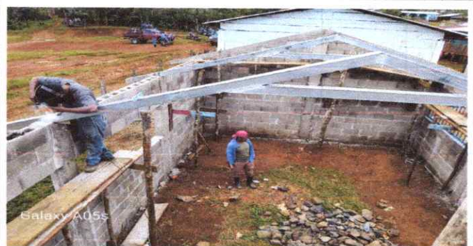
FOTO 2: INSTALACION DE ESTRUCTURAS METALICAS
