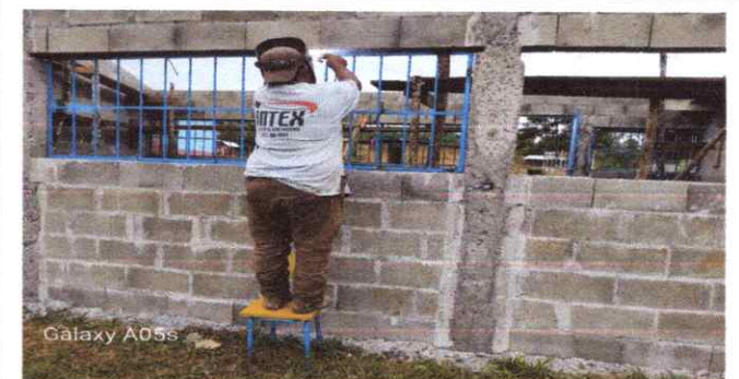
FOTO 4: FABRICACIÓN E INSTALACIÓN DE BALCONES
