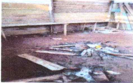
FOTO 3: Sustitucion de piso de concreto
