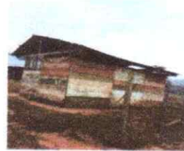
FOTO 2: Sustitucion de soporte de madera por metal
