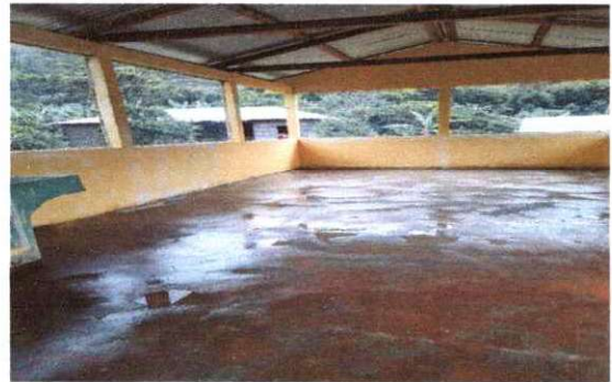
Foto 4: Sustitucion de piso de torta de concreto de cocina.
