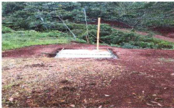
Foto 5: Finalizacion de fosa septica.
