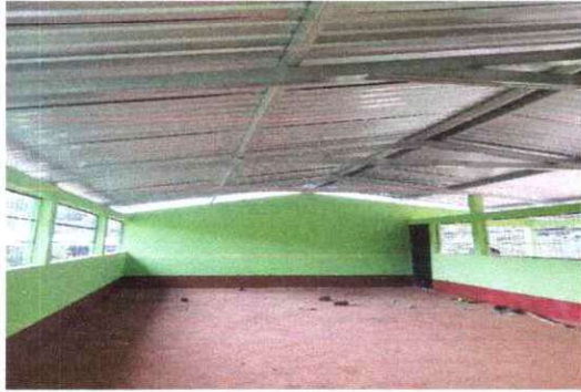
Foto1: Estructura de techo finalizada.
