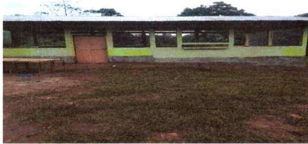
Foto 3: Finalizacion de reparacion de cocina
