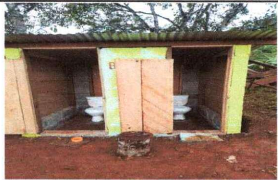
Foto 6: Sustitucion de plancha de concreto y de taza de inodoro.
