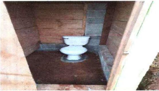
Foto 3: Sustitucion de paredes de sanitarios.
