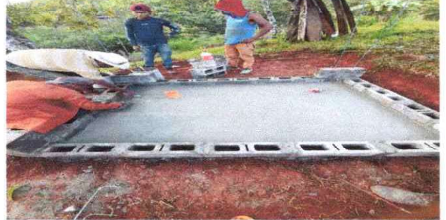
Foto 8: Sustitucion de plancha de concreto para baño.
