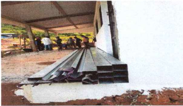
Foto 3: sustitucion de madera por metal
