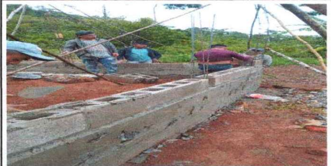
Foto 6: Trabajo de columnas de concreto para cocina.
