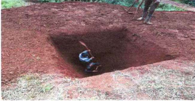
Foto 7: Ejecucion de fosa septica.
