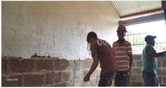
Foto1: Repello en paredes de aula
