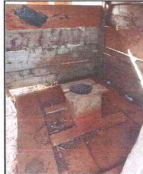
FOTO 6: Se puede observar las paredes, la taza y la plancha del sanitario en pésimo estado
