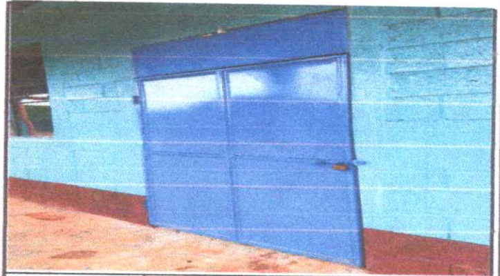
FOTO 4: SUSTITUCIÓN DE PUERTAS DE METAL.
