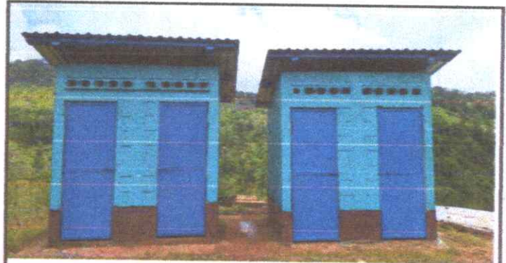
FOTO 6: SUSTITUCIÓN DE PUERTAS DE METAL DE SANITARIOS.
