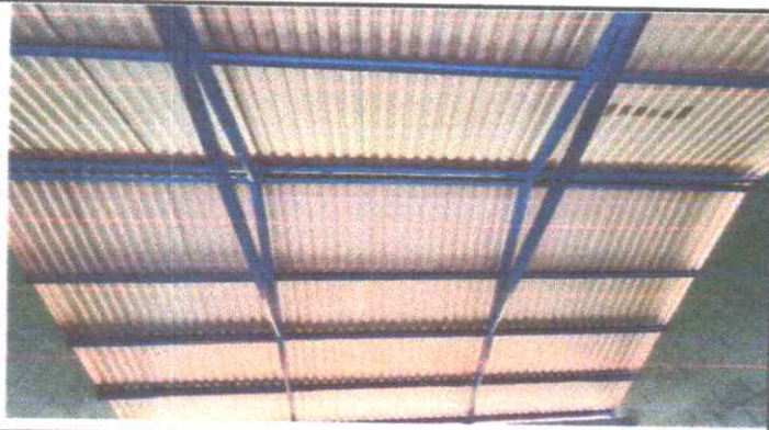
FOTO 3: SUSTITUCIÓN DE LAMINAS Y ESTRUCTURA DE TECHO.
