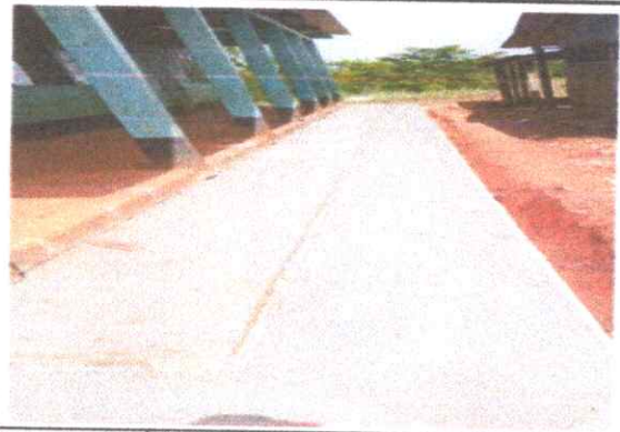
FOTO 2: FUNDICIÓN DE BANQUETA.
