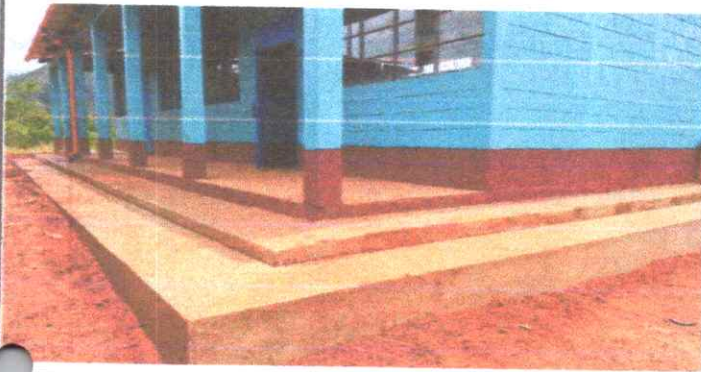
FOTO 1: FUNDICIÓN DE BANQUETA.
