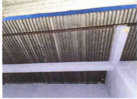
FOTO 2: SUSTITUCION DE ESTRUCTURA DE METAL
