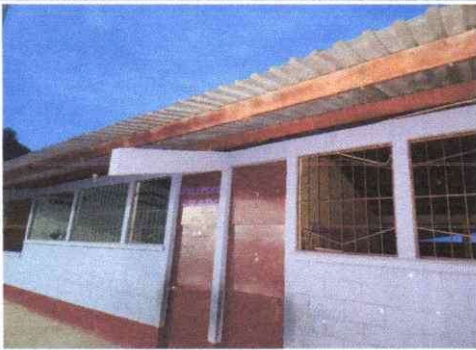
FOTO 3: MANTENIMIENTO PUERTAS DE METAL
