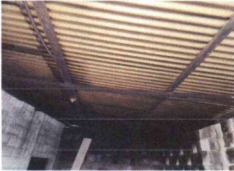
FOTO 1: SUSTITUCION DE LAMINA POR LAMINA TROQUEALDA
