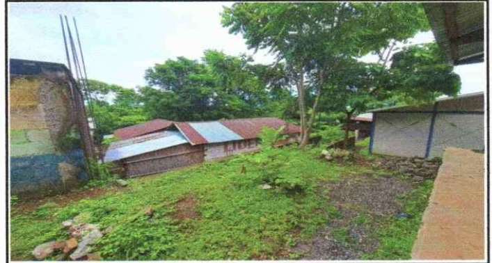
Foto 4: Reparación de muro de contención
