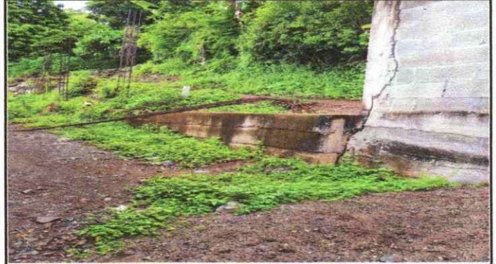
Foto 2: Reparación de muro perimetral de block
