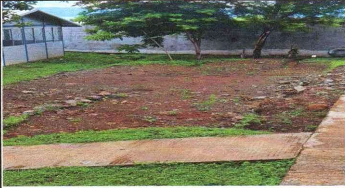
Foto 1: Reparación de plancha de concreto de patio
