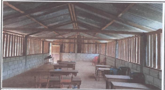
FOTO 2: SUSTITUCION DE ESTRUCTURA DE MADERA, POR METAL
