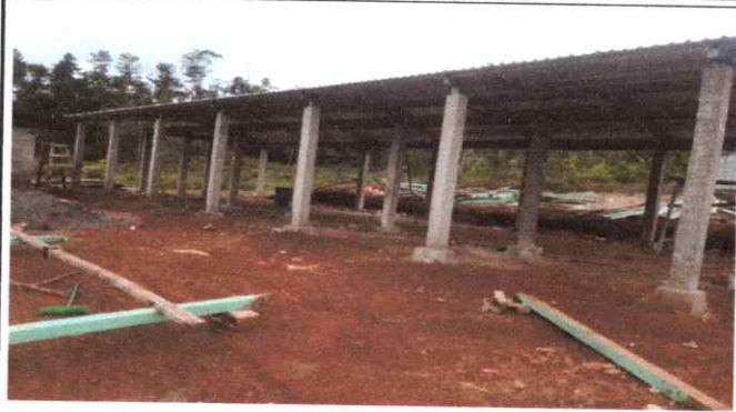
FOTO 1: LEVANTAMIENTO DE COLUMNA DE CONCRETO.
