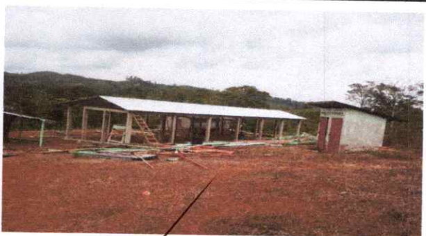
Foto 6: SUSTITUCIÓN DE LAMINA TROQUELADA.
