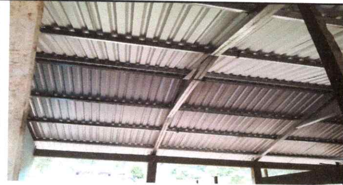
FOTO 3: SUSTITUCIÓN DE ESTRUCTURA METALICA.
