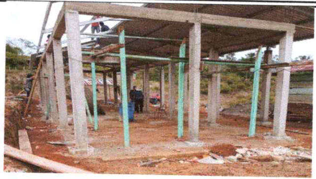
FOTO 2: LEVANTAMIENTO DE COLUMNA DE CONCRETO.
