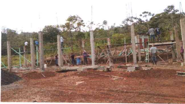
FOTO 3: SUSTITUCIÓN DE ESTRUCTURA METALICA.
