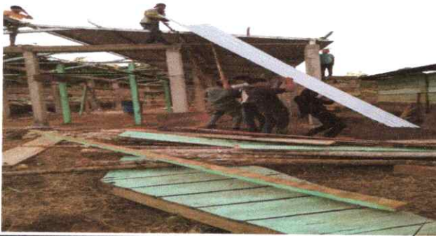
Foto 5: SUSTITUCIÓN DE LAMINA TROQUELADA.
