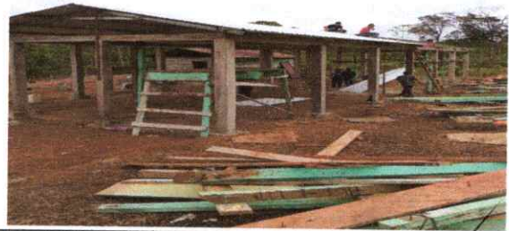
Foto 6: SUSTITUCIÓN DE LAMINA TROQUELADA.
