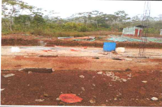
FOTO 1 : LEVANTAMIENTO DE COLUMNA DE CONCRETO
