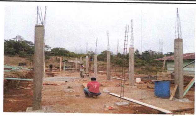
FOTO 2: LEVANTAMIENTO DE COLUMNA DE CONCRETO.
