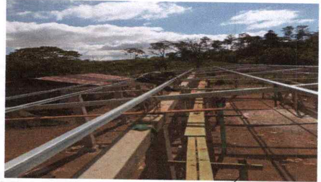
SUSTITUCIÓN DE ESTRUCTURA METALICA.
