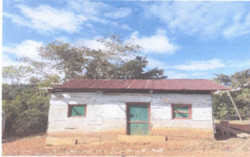
FOTO 1: SUSTITUCION DE LAMINA
