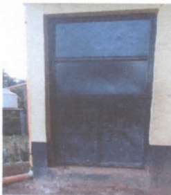
FOTO 3: SUSTITUCION DE PUERTAS DE METAL
