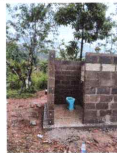
FOTO 5: REMODELACION Y LEVANTADO DE MURO PARA BAÑOS
