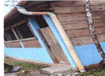
FOTO 4: INSTALACION DE CANALES DE LLUVIA
