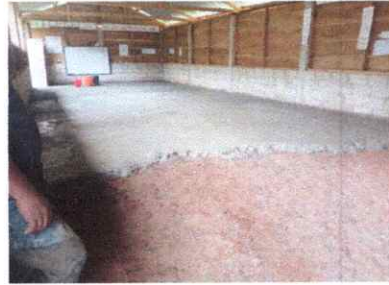
FOTO 2: REPARACION DE PISO TORTA
