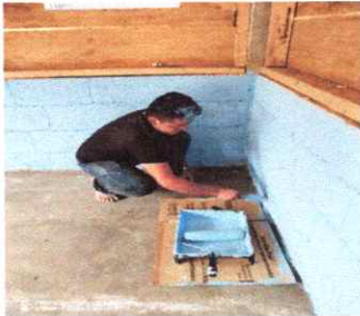
FOTO 3: PINTURA EN MUROS INTERIOR Y EXTERIOR
