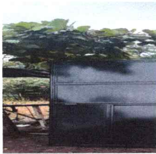
FOTO 1: SUSTITUCION DE PUERTAS DE MADERA POR METAL
