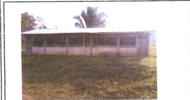
FOTO 3: PINTURA EN MUROS INTERIOR Y EXTERIOR
