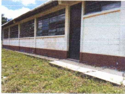
FOTO 1: Sustrucción de lámina, por lámina troquelada aluzinc calibre 26
