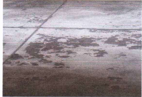
FOTO 2: Reparación de Piso Ceramico
