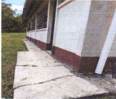
FOTO 3: Pintura en muros exteriores e interiores
