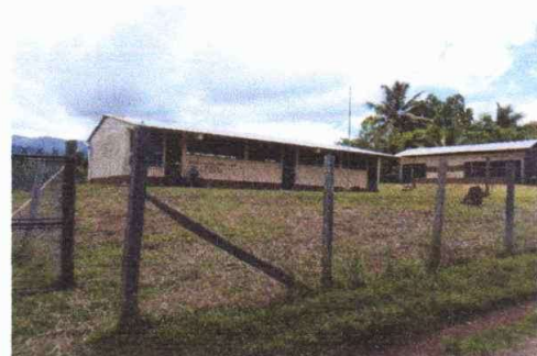
FOTO 4: Reparación de muro perimetral
