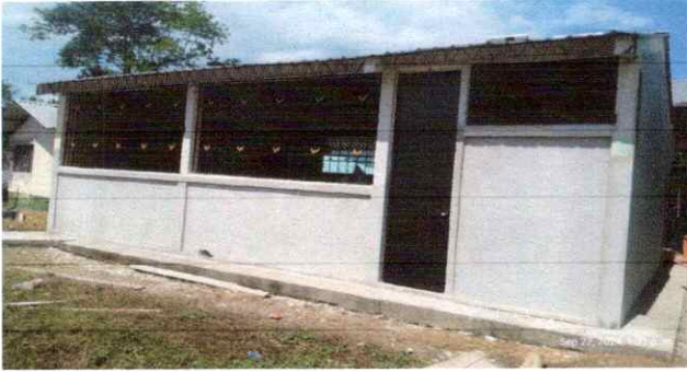
Foto1: SUSTITUCIÓN DE VENTANAS Y BALCONES.
