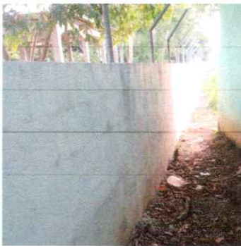
Foto 5: SUSTITUCIÓN DE MALLA / MURO PERIMETRAL
