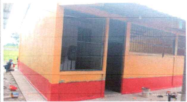
Foto 2: REPELLO Y CERNIDO DE PAREDES, PINTURA EXTERIOR E INTERIOR DE LAS AULAS
