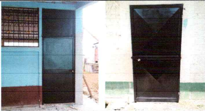
Foto 3: SUSTITUCIÓN DE PUERTA
