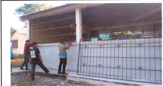
Foto1: SUSTITUCIÓN DE BALCONES Y VENTANAS
