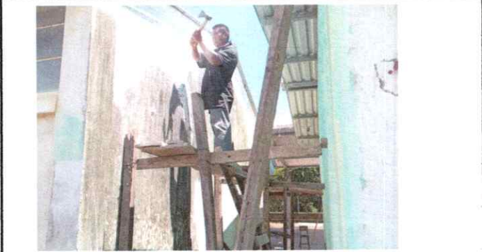
Foto 2: REPELLO Y CERNIDO DE PAREDES, PINTURA EXTERIOR E INTERIOR DE AULAS
