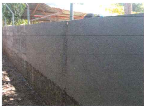
Foto 5: SUSTITUCIÓN DE MALLA / MURO PERIMETRAL
