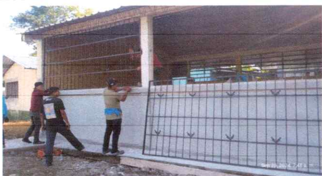
Foto 1: SUSTITUCIÓN DE BALCONES Y VENTANAS
