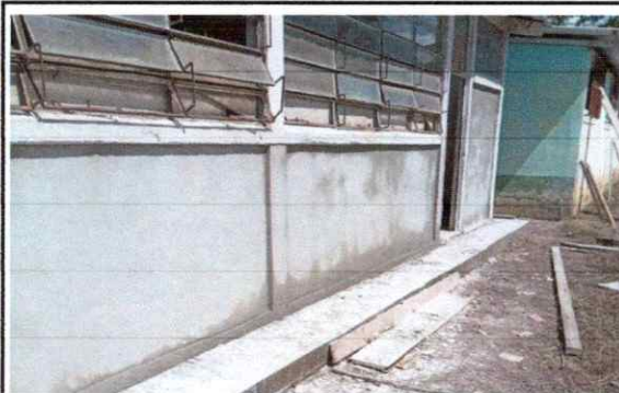
Foto 4: REPELLO Y CERNIDO DE MURO EXTERIOR E INTERIOR DE LA LETRINA. PINTURA / SUSTITUCIÓN DE PUERTAS
