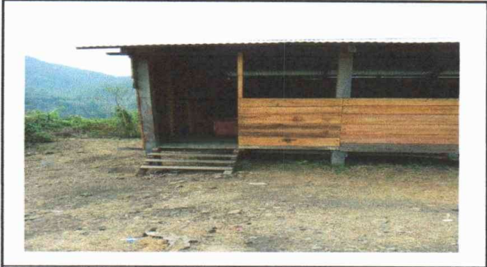
Foto 3: Sustitución de puerta de madera por metal
