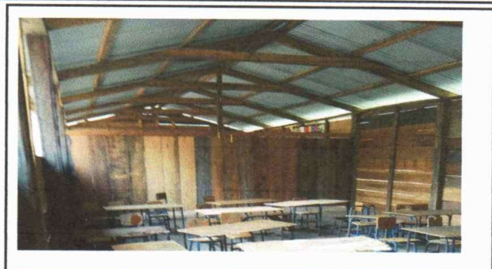
Foto 2: Sustitución de estructura de madera por metal
