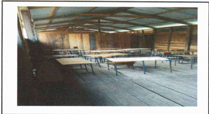
Foto 4: Reparación de piso de torta de concreto
