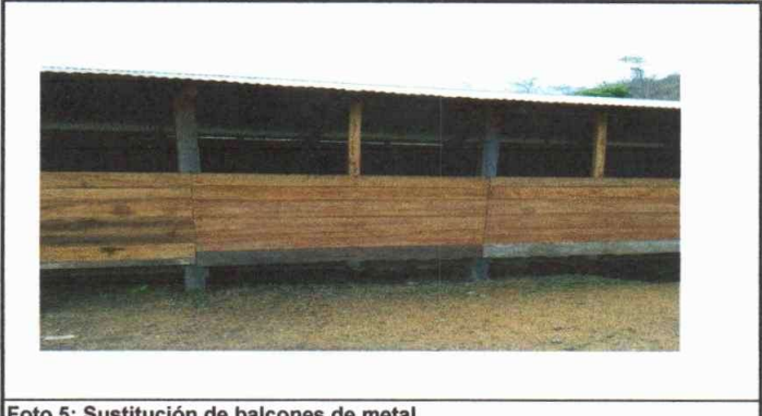
Foto 5: Sustitución de balcones de metal
