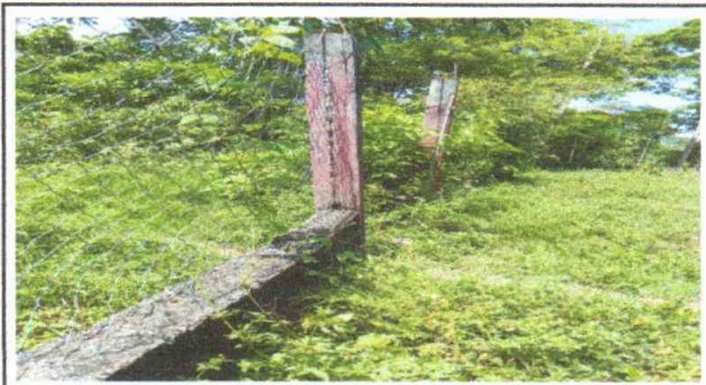
Foto 2: Reparación de muro perimetral de block con tubo hg y malla galvanizada, soleras intermedias y columnas.
