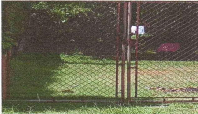
Foto1: Sustrucción de portón de metal.
