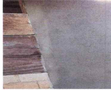
FOTO 4: CERNIDO DE PAREDES INTERIOR Y EXTERIOR
