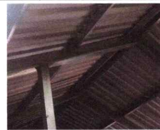
FOTO 6: SUSTITUCION DE ESTRUCTURA DE MADERA POR METAL
