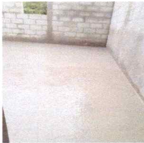
FOTO 5: REPARACION DE PISO TORTA
