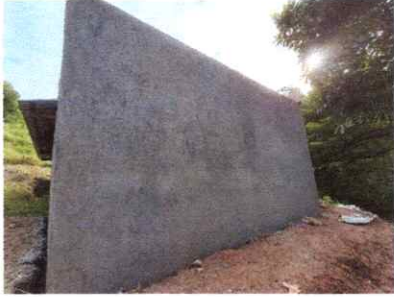
FOTO 1: LEVANTADO DE PAREDES PARA DIRECCION
