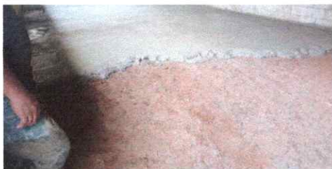
FOTO 5: REPARACION DE PISO TORTA
