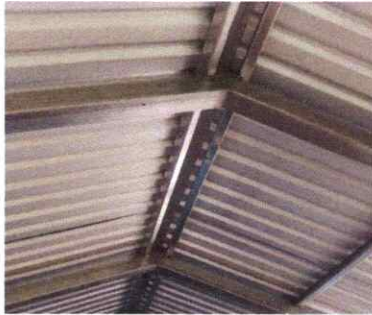
FOTO 7: SUSTITUCION DE LAMINA POR LAMINA TROQUEALDA
