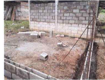
FOTO 2: LEVANTADO DE PAREDES PARA DIRECCION
