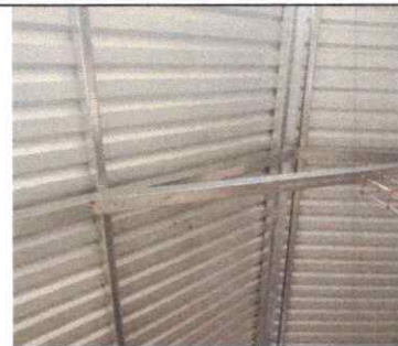
FOTO 6: SUSTITUCION DE ESTRUCTURA DE MADERA POR METAL
