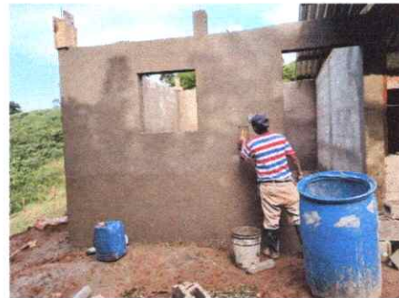
FOTO 4: CERNIDO DE PAREDES INTERIOR Y EXTERIOR
