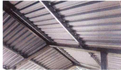
FOTO 8: SUSTITUCION DE LAMINA POR LAMINA TROQUELADA
