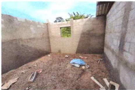
FOTO 3: CERNIDO DE PAREDES INTERIOR Y EXTERIOR
