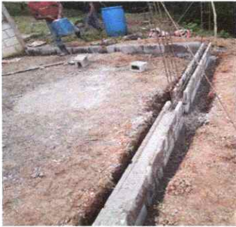
FOTO 1: LEVANTADO DE PAREDES PARA DIRECCION
