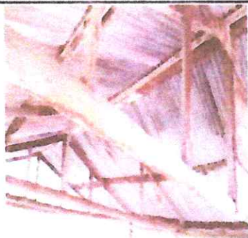
FOTO 1: SUSTITUCION DE LAMINA POR LAMINA TROQUEALDA
