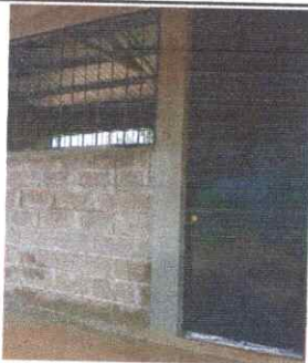
Foto 3: SUSTITUCIÓN DE PUERTAS
