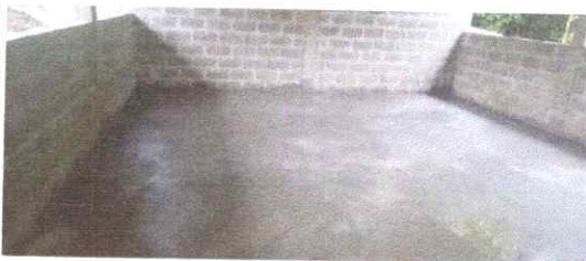
Foto 5: SUSTITUCIÓN DE PISO DE TORTA DE CONCRETO
