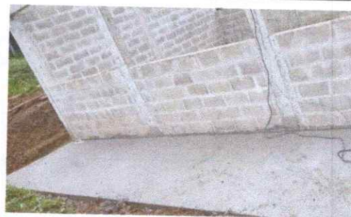
Foto 6: SUSTITUCIÓN DE BANQUETAS DE CONCRETO
