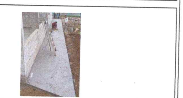
Foto 6: SUSTITUCIÓN DE BANQUETAS DE CONCRETO
