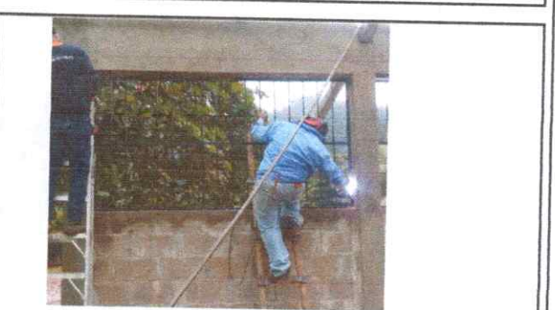
Foto 4: SUSTITUCIÓN DE BALCONES DE METAL
