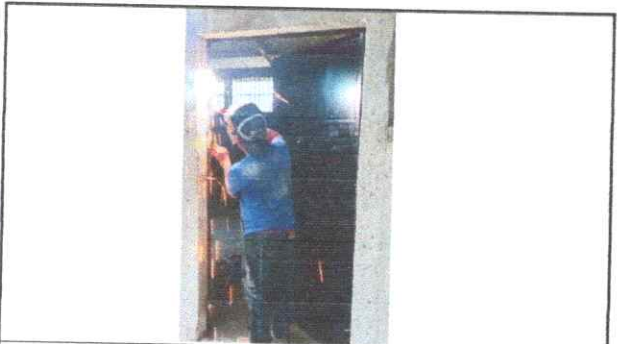
Foto 3: SUSTITUCIÓN DE PUERTAS
