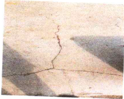
FOTO 1: Sustitucion de piso de concreto
