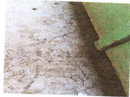
FOTO 2: Sustitucion de piso de concreto
