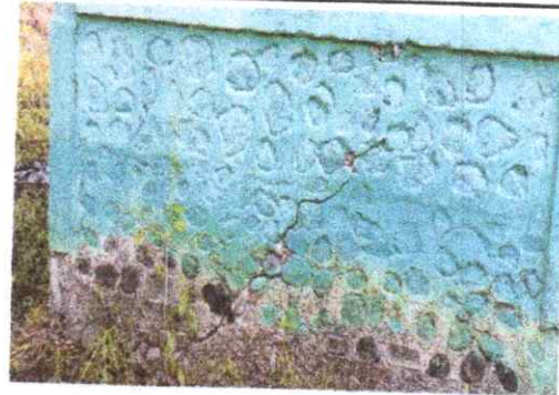
FOTO 4: Reparacion, sellado, fisuras de paredes
