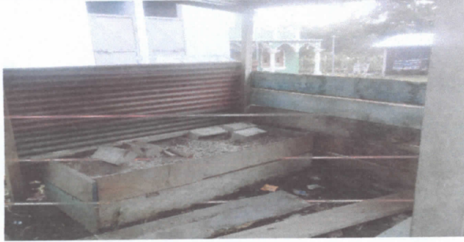
Sustitución torta de tierra por piso de cemento
