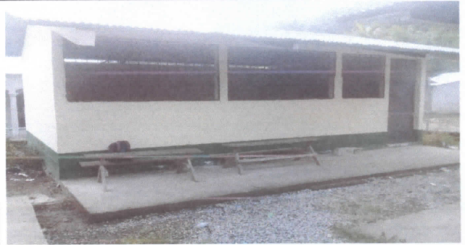
Pintura en muros exteriores e interiores
