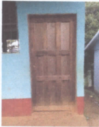
FOTO 3: SUSTITUCION DE PUERTAS
