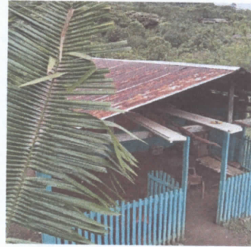
FOTO 2: SUSTITUCION DE LAMINA DE COCINA
