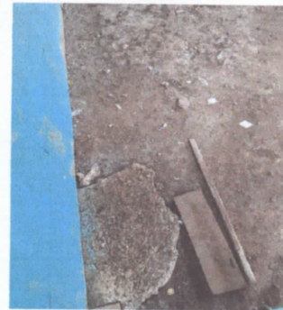
FOTO 4: SUSTITUCION DE PISO
