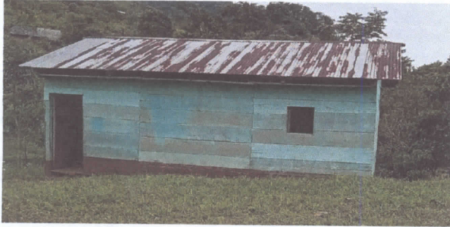
FOTO 1: SUSTITUCION DE LAMINA
