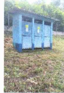
FOTO 2: Sustitucion de puertas de baño
