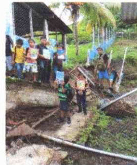
FOTO 6: Sustitucion de muro perimetral
