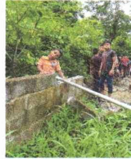
FOTO 4: Sustitucion de muro perimetral
