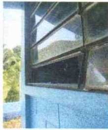
FOTO 3: Pintura en muros exteriores e interiores
