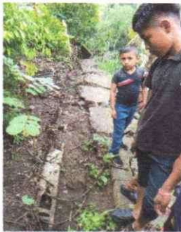
FOTO 5: Sustitución de muro perimetral
