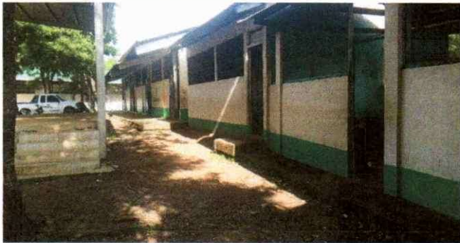
Foto 3: Pintura en muros exteriores
