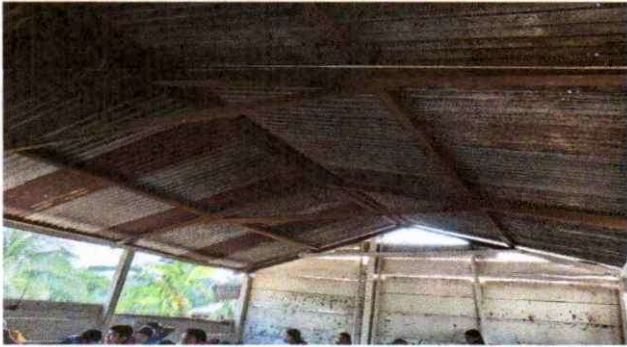
Foto1: Sustitución de lámina.
