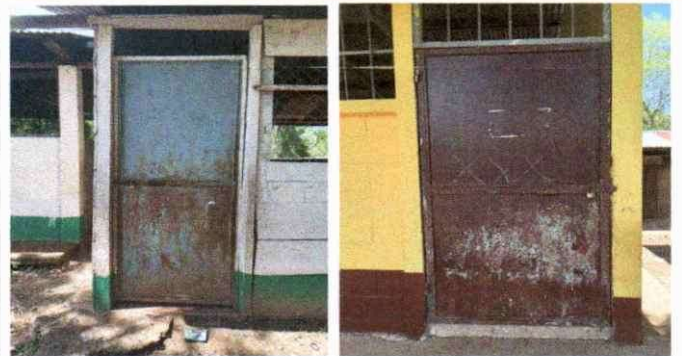
Foto 2: Mantenimiento de puertas principales.
