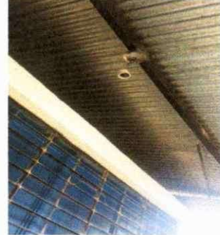
Foto 2: Reparación de sistema eléctrico
