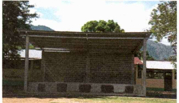
Foto 4: Repello de muro
