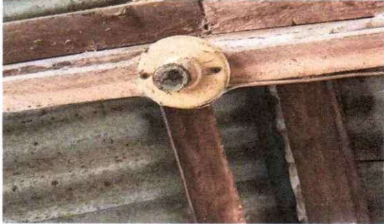
Foto1: Reparación de sistema eléctrico
