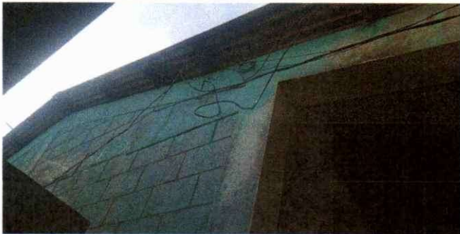
Foto 5: Reparación de sistema eléctrico
