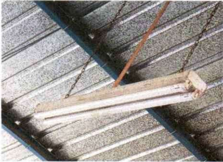
Foto 3: Reparación de sistema eléctrico
