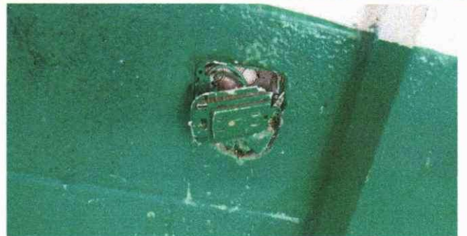
Foto 6: Reparación de sistema eléctrico
