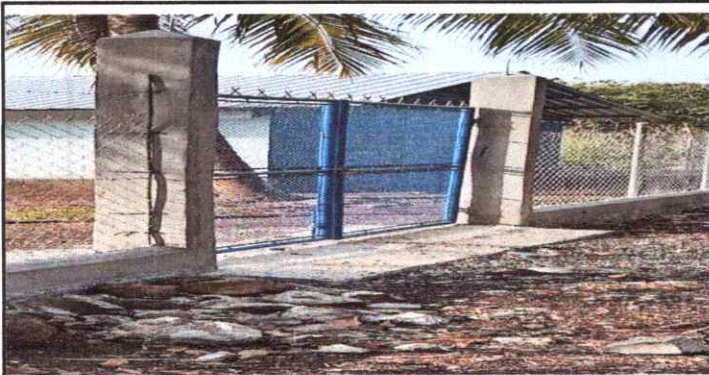
FOTO 3: SUSTITUCIÓN DEL PORTÓN EN LA ENTRADA.
