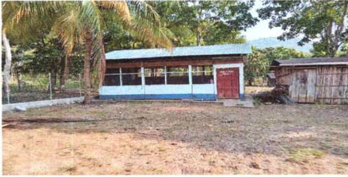
FOTO 1: SUSTITUCIÓN DE LAMINA, POR LÁMINA ACANALADA ALUZINC CALIBRE 28.
