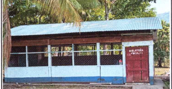
FOTO 2: SUSTITUCIÓN DE LAMINA, POR LÁMINA ACANALADA ALUZINC CALIBRE 28.
