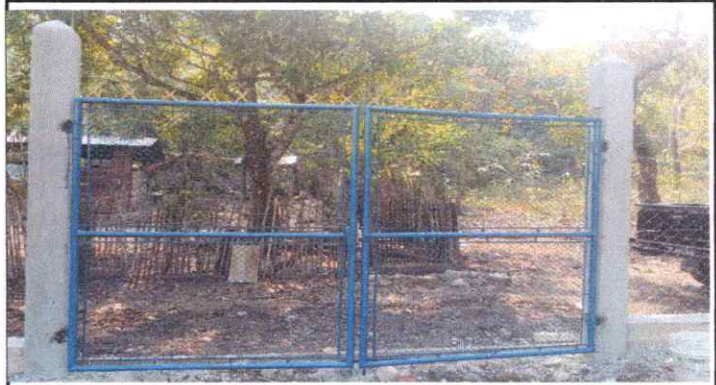
FOTO 4: SUSTITUCIÓN DEL PORTÓN EN LA ENTRADA.
