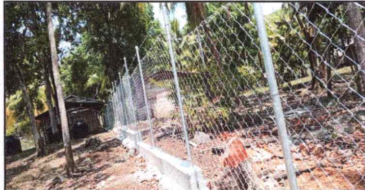
FOTO 6: REPARACIÓN DE MURO PERIMETRAL DE BLOCK CON TUBO HG Y MALLA GALVANIZADA, SOLERA INTERMEDIAS Y COLUMNAS.
