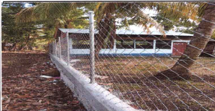
FOTO 5: REPARACIÓN DE MURO PERIMETRAL DE BLOCK CON TUBO HG Y MALLA GALVANIZADA, SOLERA INTERMEDIAS Y COLUMNAS.
