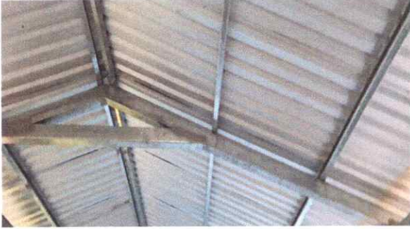
Foto 1: SUSTITUCION DE ESTRUCTURA DE MADERA POR METAL
