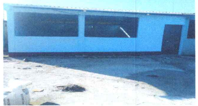
Foto 2: SUSTITUCIÓN DE LAMINAS ZINC POR LAMINA TROQUELADA CALIBRE 26
