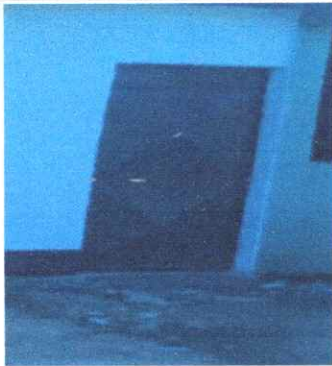
Foto 3: SUSTITUCION DE PUERTA DE MADERA POR METAL
