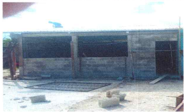
Foto 2: SUSTITUCIÓN DE LAMINAS ZINC POR LAMINA TROQUELADA
