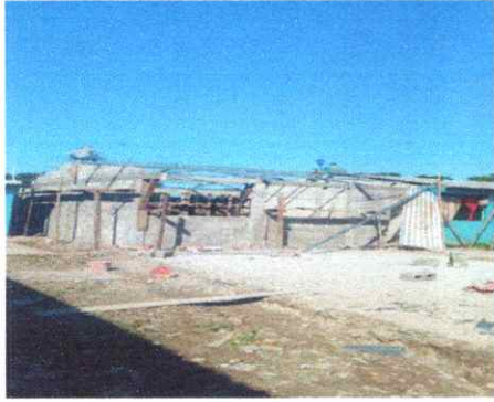
Foto1: SUSTITUCION DE ESTRUCTURA DE MADERA POR METAL
