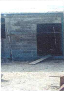
FOTO 4: SUSTITUCIÓN DE PUERTA DE MADERA POR METAL
