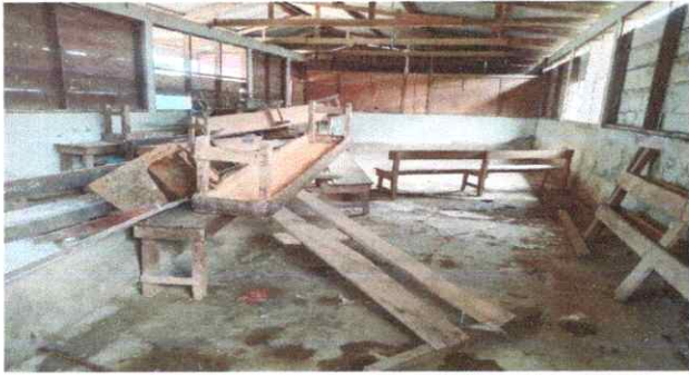
FOTO 1: Sustitución de Estructura de madera por metal.
