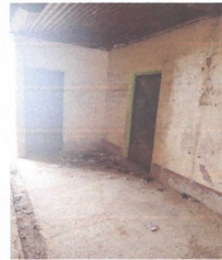
FOTO 4: SUSTITUCIÓN DE PUERTAS
