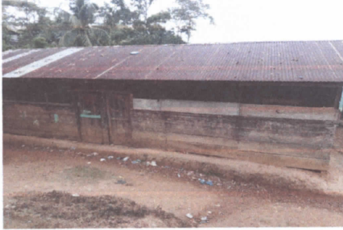
FOTO 1: SUSTITUCIÓN DE LÁMINA
