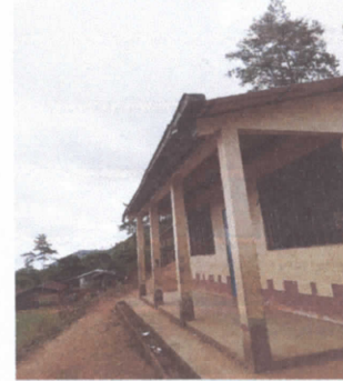
FOTO 2: SUSTITUCIÓN DE BALCONES Y VENTANAS
