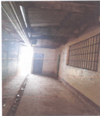
FOTO 3: SUSTITUCIÓN DE PISO TORTA DE CEMENTO
