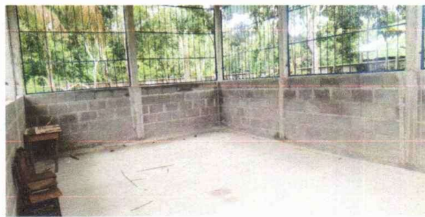
Foto 4.2: Sustitución de piso cerámico
