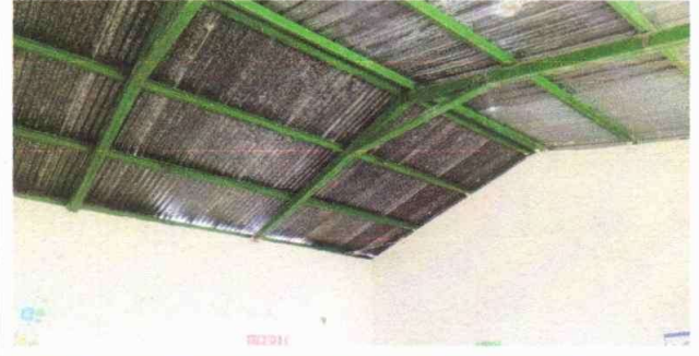
Foto 2: Mantenimiento a estructura de soporte de metal
