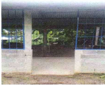
Foto 3: Sustitución de puerta
