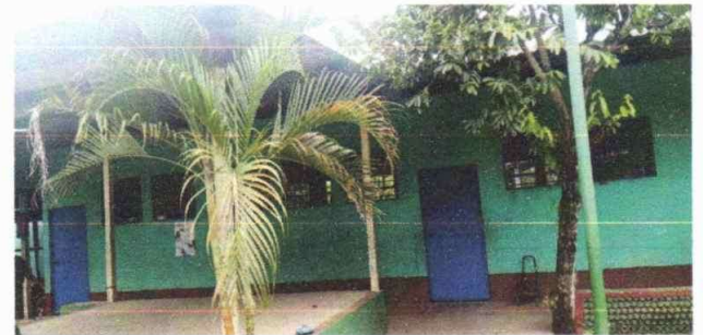
Foto 5: Pintura en muros exteriores
