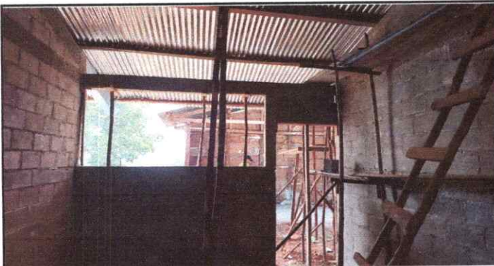
Foto #3 Colocacion de lamina del techo de 1 aula y direccion del centro educativo.
