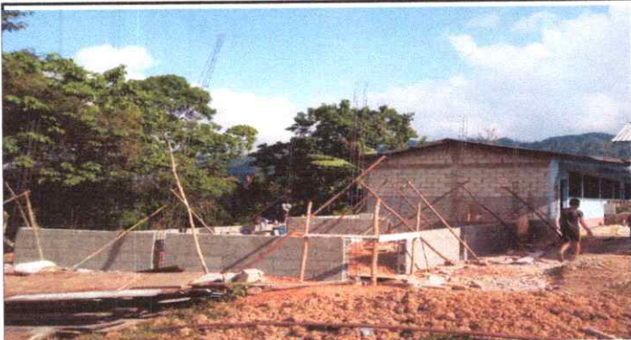
Foto #1 Construcción del espacio de 1 aula y direccion del centro educativo.
