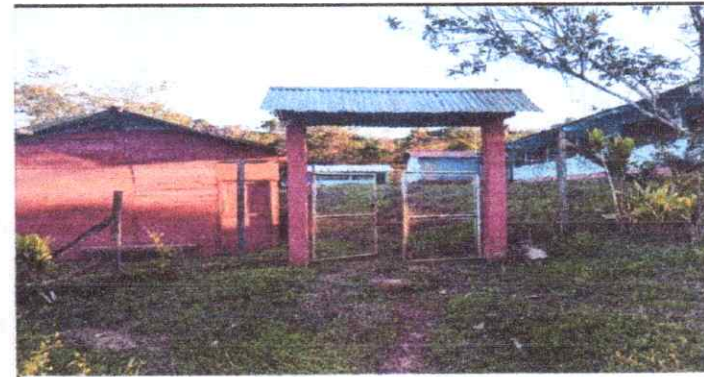
FOTO 6 SUSTITUCION DE PORTON
