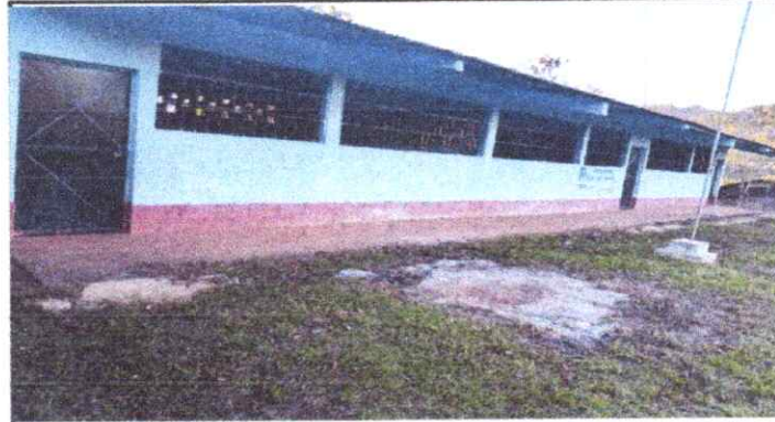
FOTO 2 SUSTITUCION DE BALCONES
