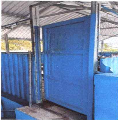
Foto 3: Sustitución de estructura de soporte de madera por metal
