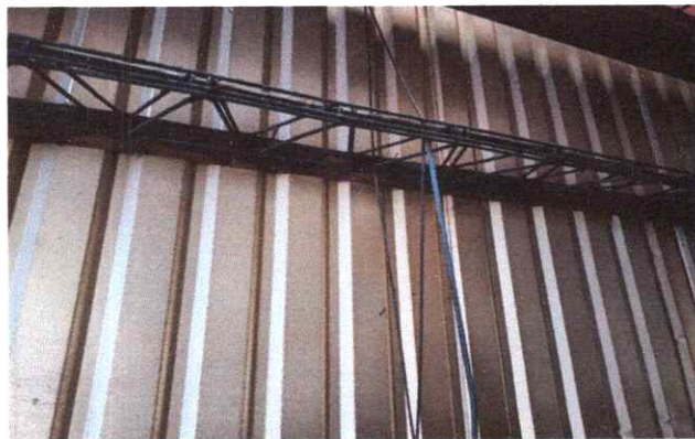
Foto 3: Sustitución de estructura de soporte de metal por metal.
