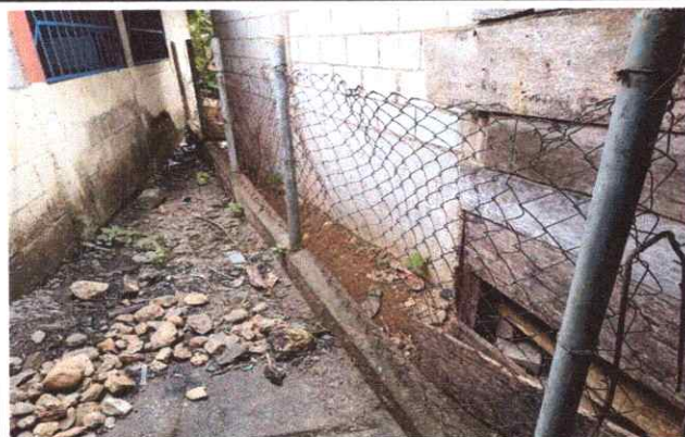
Foto 5: Reparación de muro perimetral de block.
